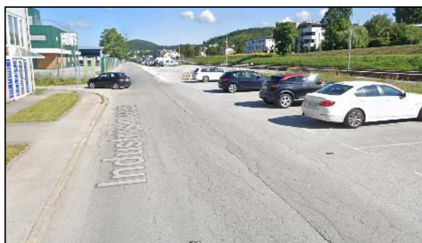
Slika 10: Slabo stanje voziščne konstrukcije na koncu območja obdleave.
