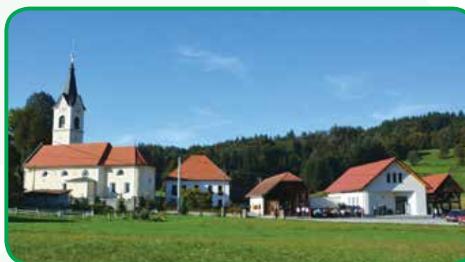
Posodobljen kompleks župnijskega središča v Žalni z novim domom svetega Lovrenca.
