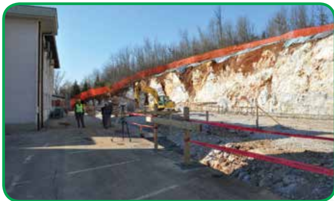
Vzdolž hriba, desno od zdravstvenega doma, smo odstranili vrhnji sloj zemljine, zdrobili spodaj ležeče kamnine in izkopal veliko gradbeno jamo.
