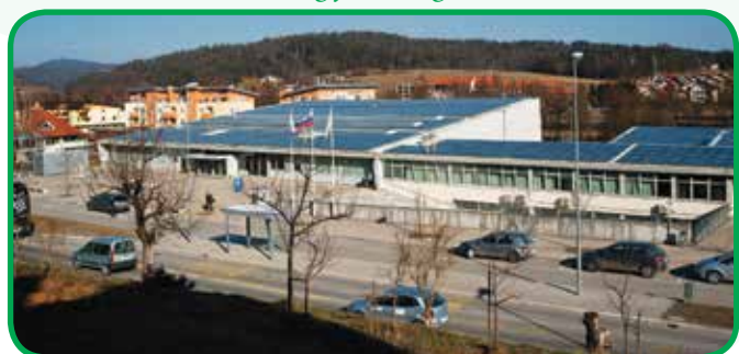
Sončno elektrarno sestavlja 1729 fotonapetostnih modulov, ki naj bi letno predvidoma proizvedli 444 megavatnih ur električne energije in prihranili več kot 266 ton izpustov ogljikovega dioksida v ozračje.
