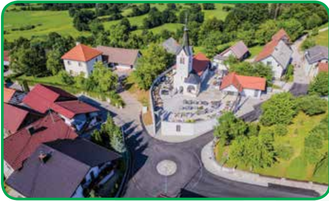
Pogled na trg, novo obzidje pokopališča in na vežico.
